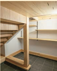
玄関脇の収納は階段下を利用
