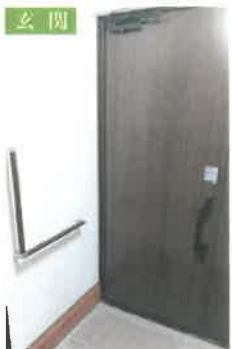
玄関ドアを断熱ドアに取替え内側の結露も解消。また玄関に手すりを取り付け出入りも快適に。
