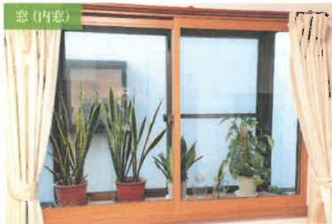
出窓に内窓を設置し、断熱効果が抜群に。電気代の節約にも効果的。
