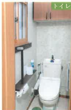
トイレも内窓で断熱効果アップ。
