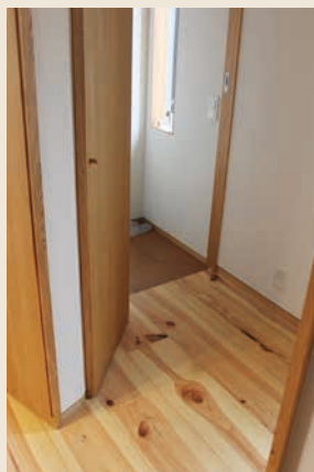
▲二階に上がったところ。入口への扉が斜めについているのは狭い踊り場を使いやすくする工夫です。
