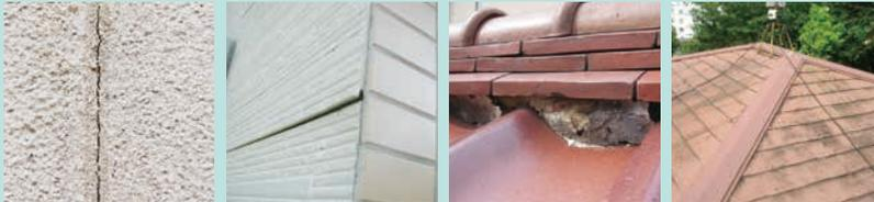
モルタル壁のひび サイディングの浮き 屋根しっくいのはがれ カラーベスト屋根の焼け・苔
