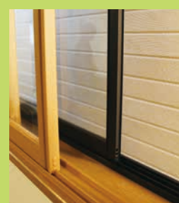
窓はすべて内窓の取り付け、またはペアガラスの複合サッシに取り換えました。
