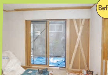
南側の3枚引き戸は、耐震性を確保するために筋交い入りの壁に変わりました。
