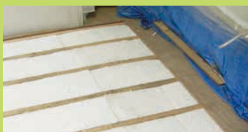
壁・床下の断熱材も取替えました。
